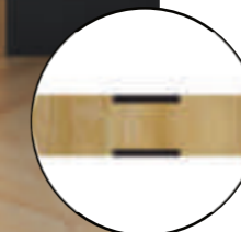
Sklo iacobel vlepno do hdf desky (6mm silná hdf). Zarovnáno s povrchem křídla.
